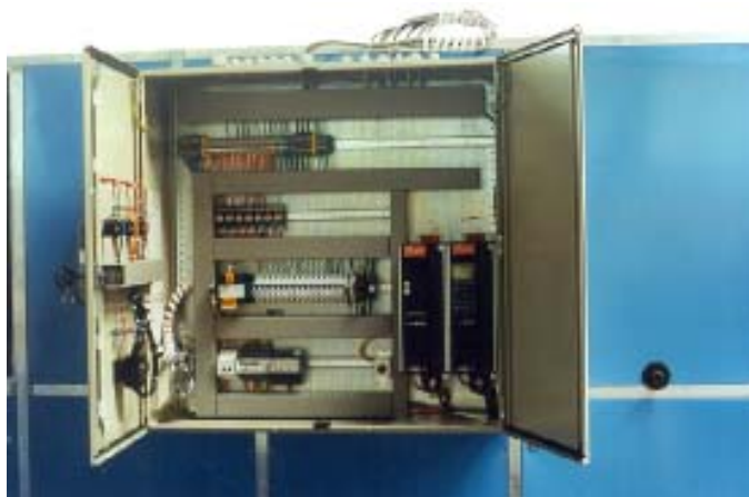
Шкаф управления, смонтированный на вентиляционной установке.
